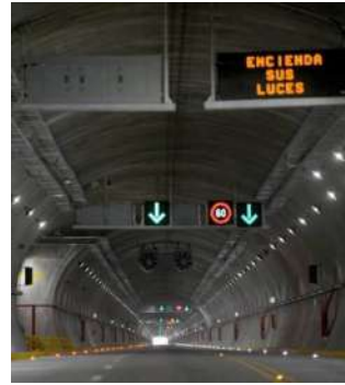
Acatúnel · Entronque Brisamar
